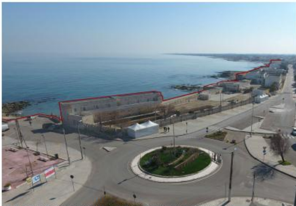
VISTA BASSA DA NORD - STATO DI FATTO CON DELIMITAZIONE MANUFATTI ESISTENTI
